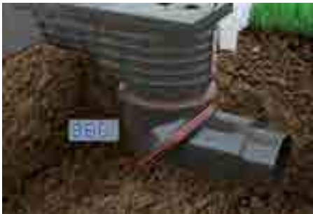
4. Richtung und Winkel des Abgangsbogens einstellen
